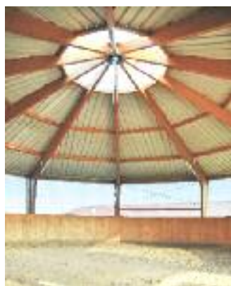
Longierhalle mit einem Durchmesser von 18 m. Sie ist bewusst hell gebaut worden und rundherum mit Windschutznetzen versehen.
