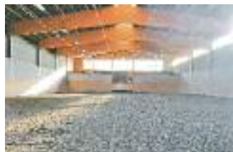
Ein Ausblick in unsere im Dez. 2012 neu erbaute Reithalle 20 x 40 m mit Beregnungsanlage und Beleuchtung.
